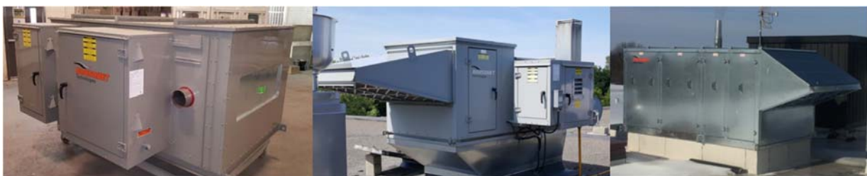
Image 1 : Unités d'apport d'air neuf de 1 re , 2 e et 3 e (à condensation) générations (de gauche à droite)
